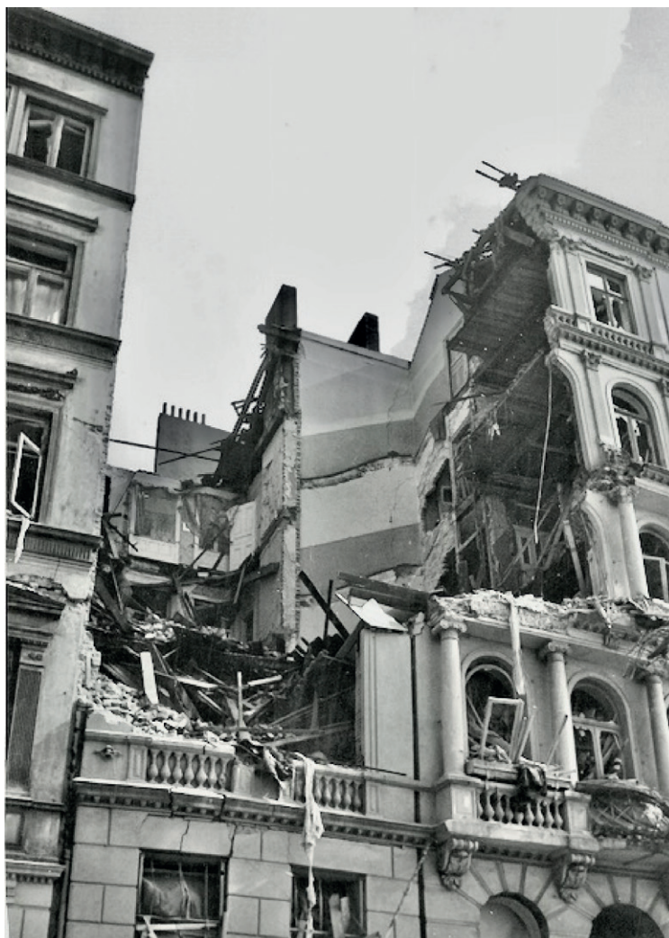
Das schwer beschädigte Gebäude Feldstraße 46
